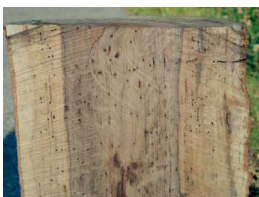
↑被害木の穿孔状態
